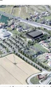
IMPIANTI L'area dove sorgeerà il nuovo palasport da circa 1000 posti
